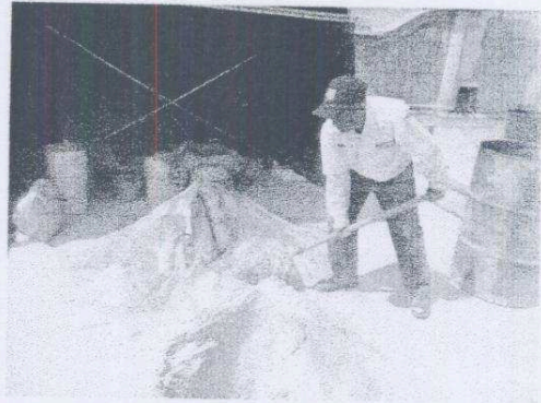
Preparación de Mortero para pegar la Baldosa Con proporción 1: 1 : ½ (arena, cal, cemento)
