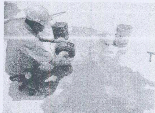
Aplicación de Mortero previo a la mezcla Proporción 1: 1 (arena de río, cemento)
