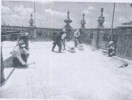
Limpeza del área de residuo de asfalto
